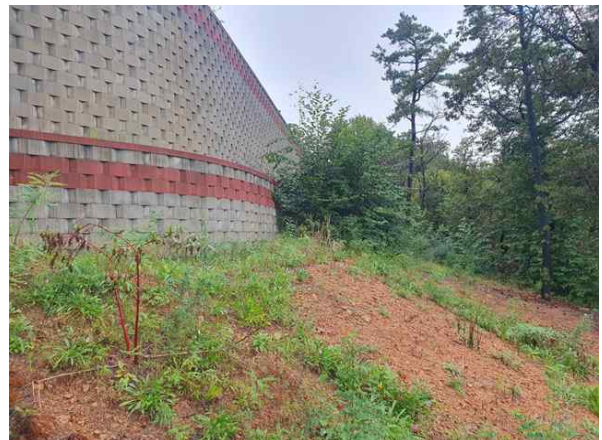
<옹벽 하부 상태양호>
