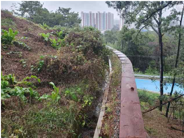
<옹벽 2단 상부 상태양호>
