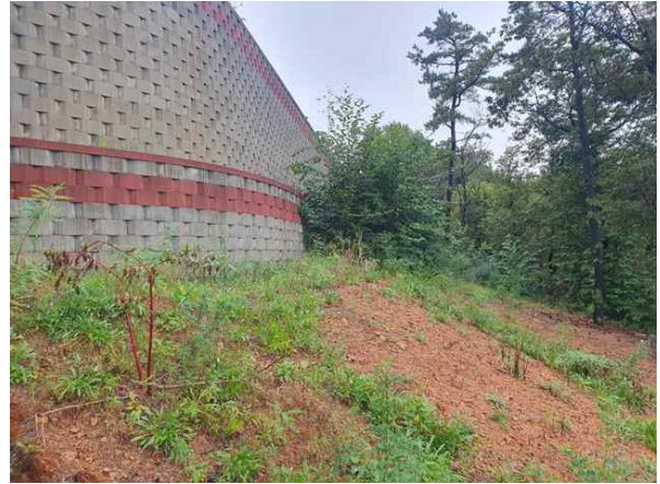
<옹벽 하부 전경>
