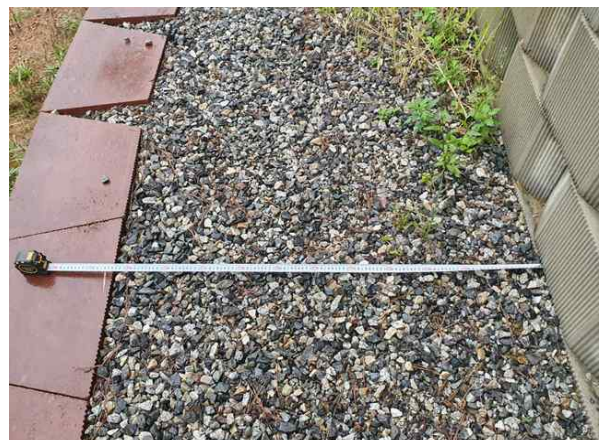
<소단 규격 상태양호>
