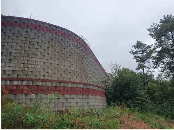
<옹벽 시점부 상태양호>
