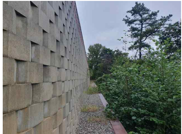
<옹벽 1단 상부 상태양호>
