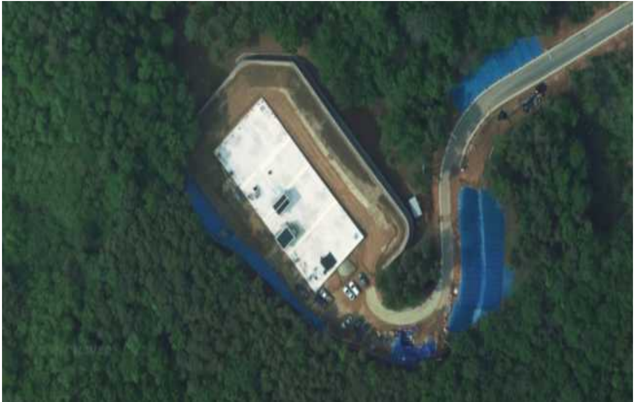
<화성비봉 공공주택지구 밖 배수지 및 진입도로 중 블록식 보강토 옹벽>
